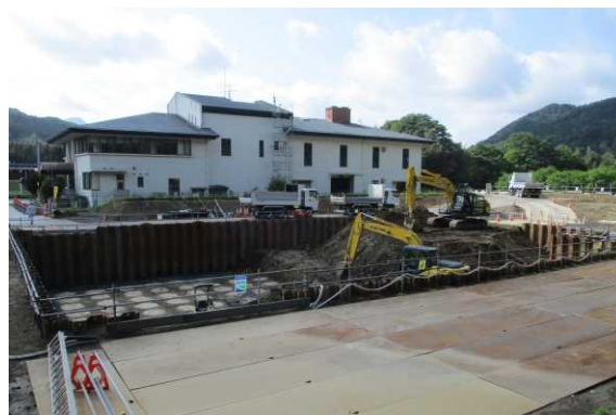
現施設の背後地に建替中の衛生センター（南田気地区）
