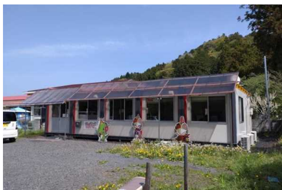
プレハブによる仮設演奏所（だいが小学校隣接地）
