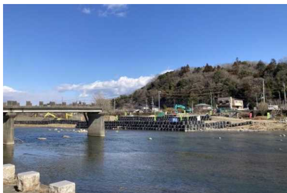
新橋の下部工
