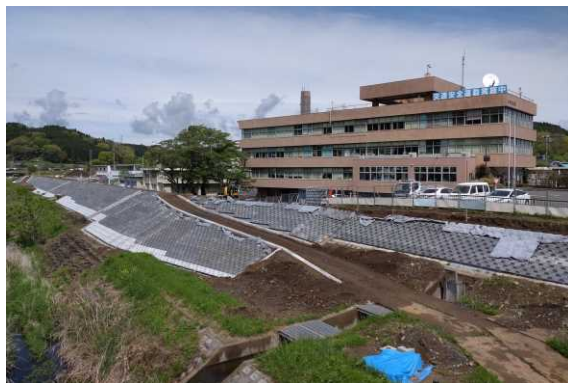
押川堤防の嵩上げ工事（旧役場付近）
