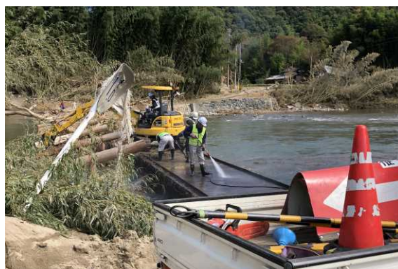
久野瀬橋（斜めの柱がゴミ受け） ※
