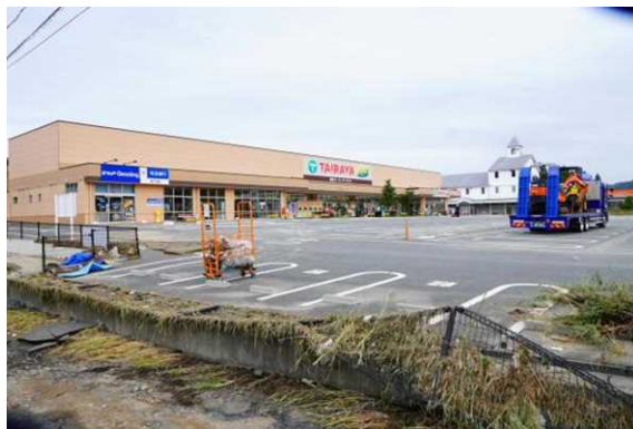
水のかで倒れたフェンス ※
