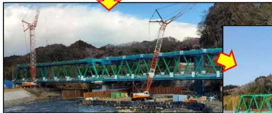
【第六久慈川橋梁・復興（建設中）】
