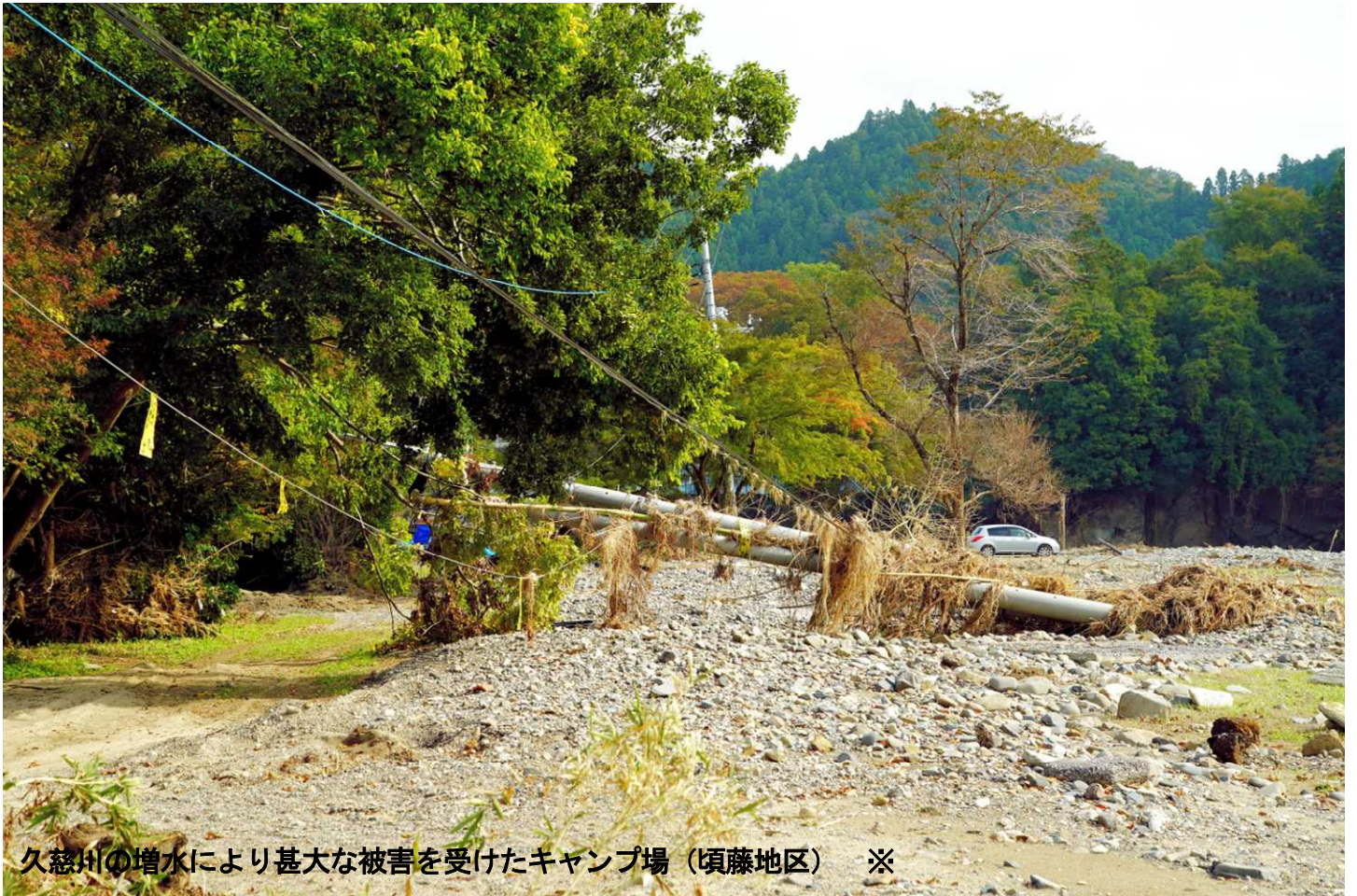
増水して濁流と化した久慈川（南田気橋） ※
