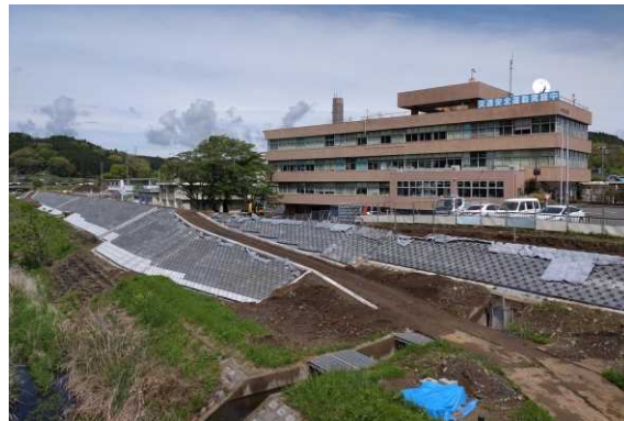
押川堤防の嵩上げ工事（旧役場付近）
