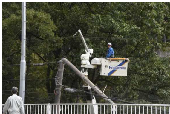
電力会社による復旧作業
