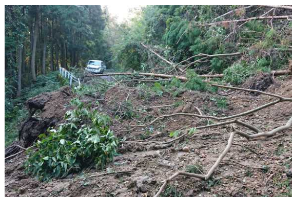
土砂流出・倒木（大生瀬地内）
