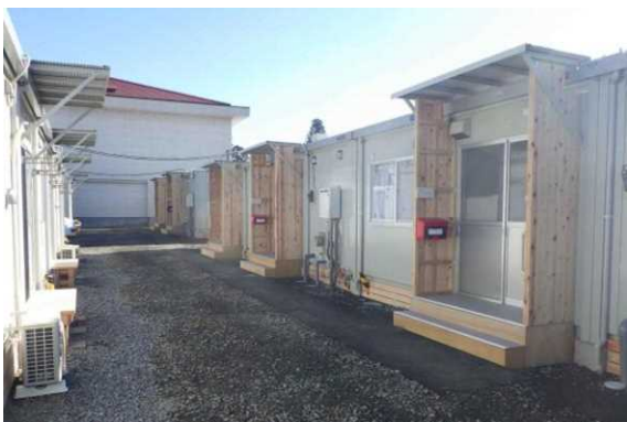
大子仮設住宅（だいが小学校敷地内）
