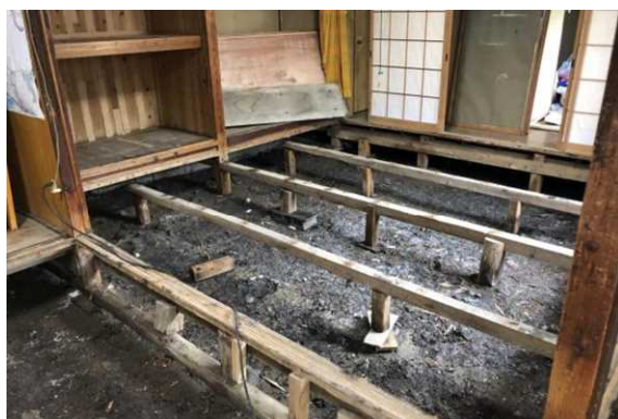
床板を剥がして消石灰の散布（大子地区） ※
