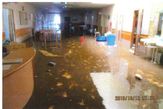
被災後の施設内
