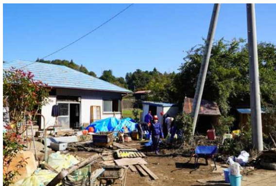
災害ボランティアによる泥の除去作業（北田気地区） ※
