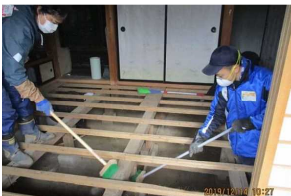
床下の泥出し作業
