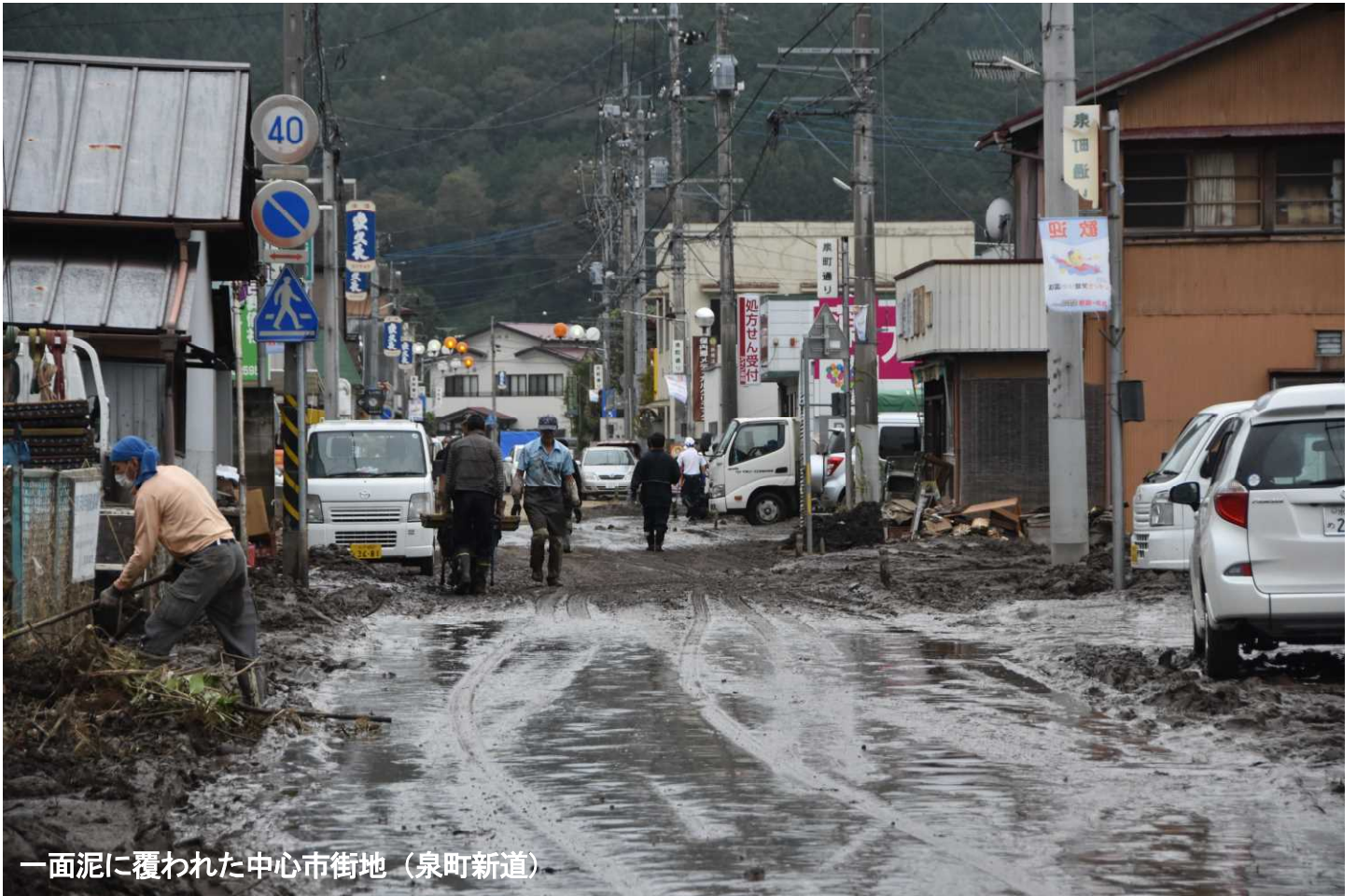
浸水したパチンコ店（小久慈地区） ※
