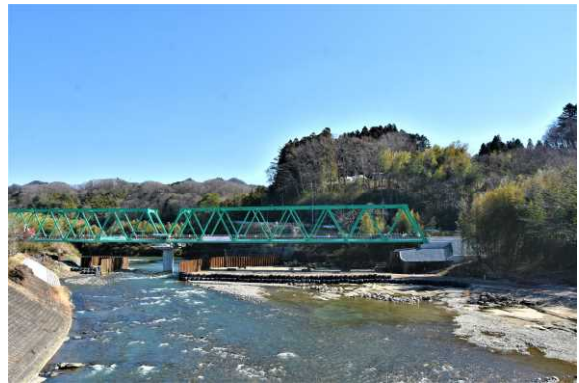
トラス橋に架け替えられた第六久慈川橋梁（袋田地区）
