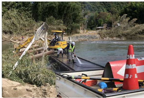
久野瀬橋（斜めの柱がゴミ受け） ※
