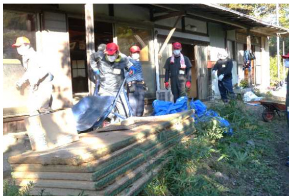
浸水した家財の搬出作業
