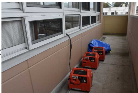
非常用発電機で電源確保
