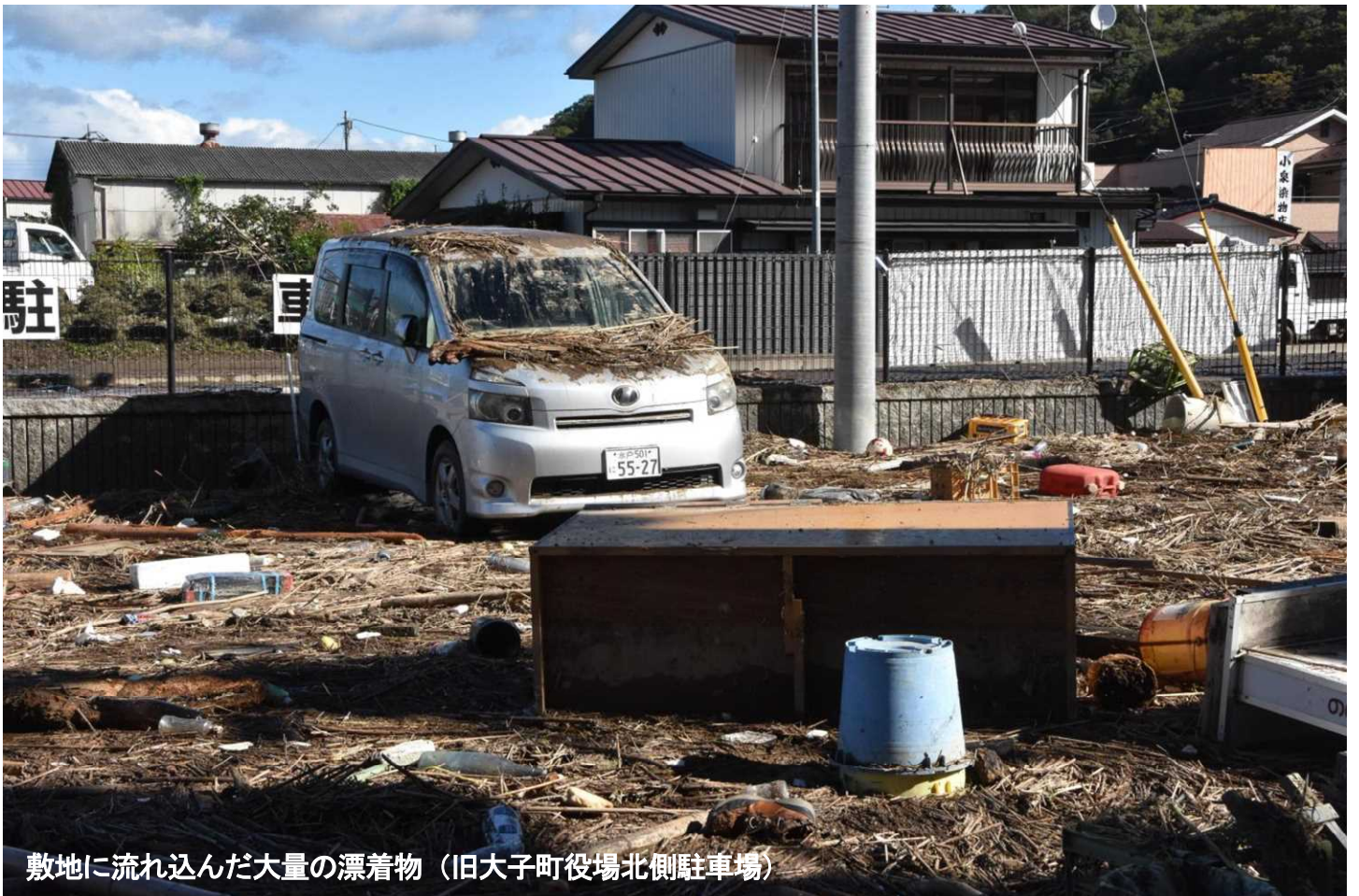
水が引いた直後の様子（国道461号旧大子町役場交差点）
