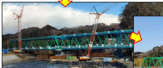
【第六久慈川橋梁・復興（建設中）】
