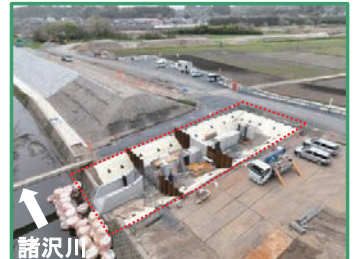
樋管の整備を行っています
