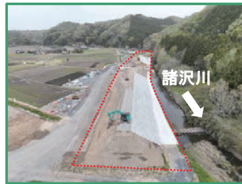
工事箇所の全景
