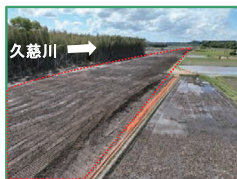
築堤の整備を行っています
