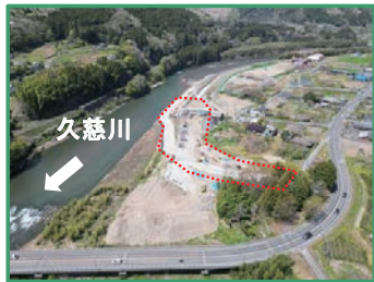
工事箇所の全景
