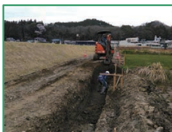
水路工事を行っています
