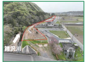
工事箇所の全景
