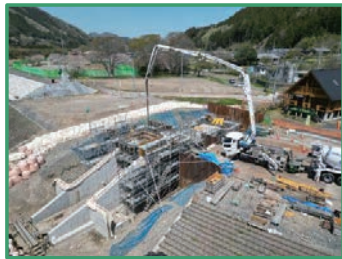
樋管箇所のコンクリート打設状況
