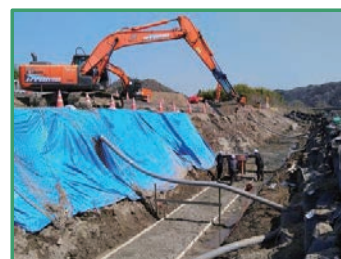
護岸ブロックの整備を行っています
