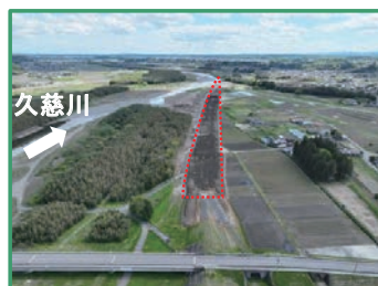
工事箇所の全景（上流から）
