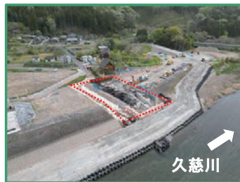
樋管箇所の全景
