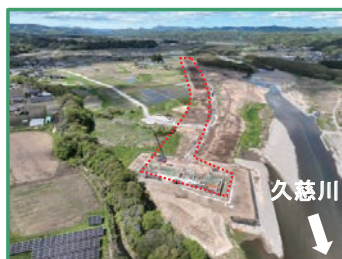
工事箇所の全景（下流から）
