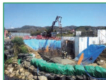
樋管の整備を行っています
