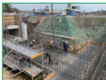
樋管の整備を行っています
