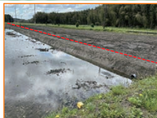
小貫北地区の畦畔設置状況
