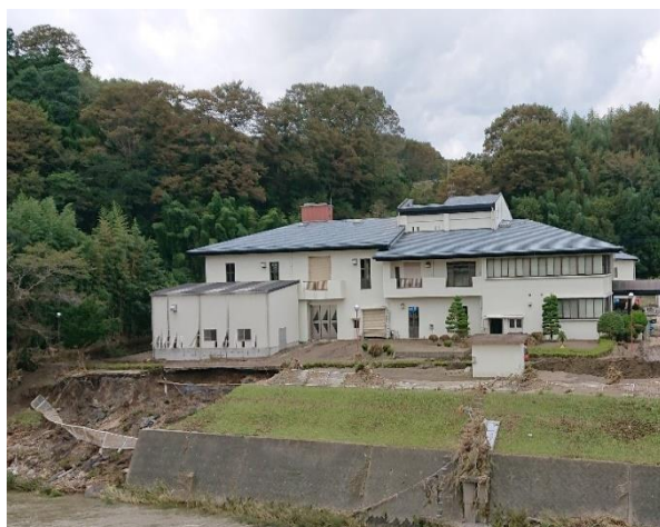
令和元年東日本台風により推定1.7m浸水被害に遭い施設機能が全停止となった衛生センター
