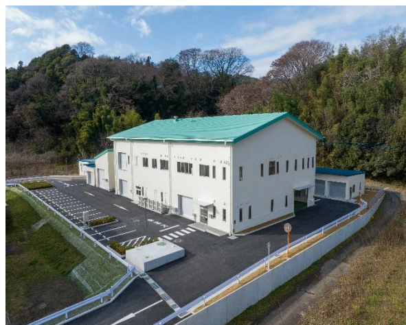
国庫補助の廃棄物処理施設災害復旧事業費補助金を活用し、令和6年3月に竣工した衛生センター
