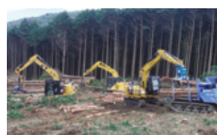
▲伐採現場の作業風景
