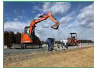
舗装止めブロックの設置を行っています
