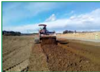
築堤材料の改良を行っています
