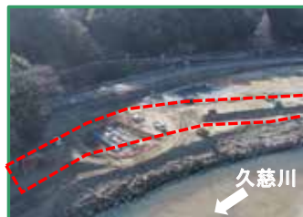
工事箇所の全景（下流から）
