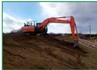
堤防盛土を行っています
