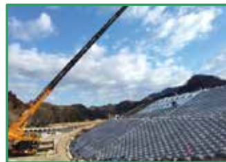
コンクリートブロックの設置を行っています
