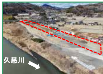
工事箇所の全景（下流から）
