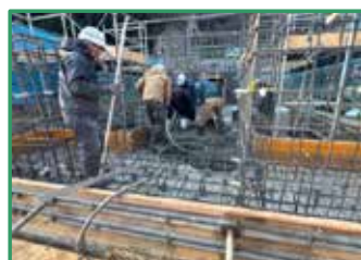
樋管のコンクリートの打設を行っています
