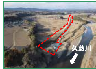
工事箇所の全景（下流から）
