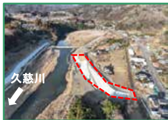
工事箇所の全景（下流から）
