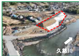
工事箇所の全景（上流から）
