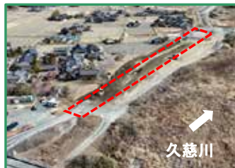
工事箇所の全景（上流から）
