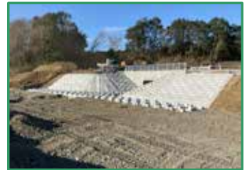
コンクリートブロック張り完了（全景）
