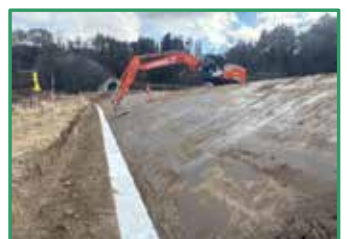
堤防盛土を行っています
