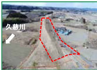
築堤箇所の全景（下流から）
