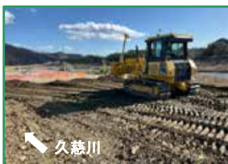
堤防盛土を行っています
