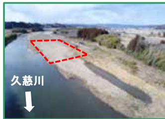
河道掘削箇所の全景（下流から）
