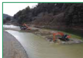
河道掘削を行っています
