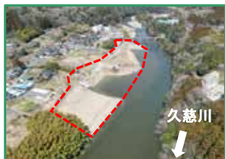
工事箇所の全景（下流から）
