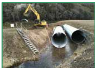
コルゲートの設置を行っています
