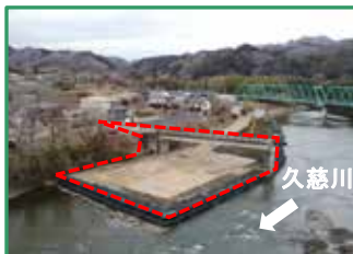
工事箇所の全景（下流から）
