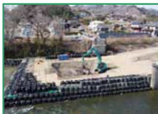
掘削作業を行っています
