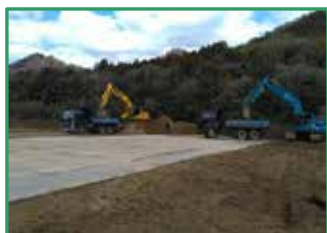
河道掘削を行っています
