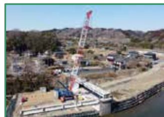
旧橋の撤去を行っています
