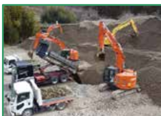
盛土材の振分けを行っています
