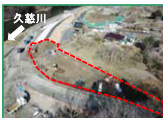
工事箇所の全景（下流から）
