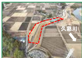
工事箇所の全景（下流から）
