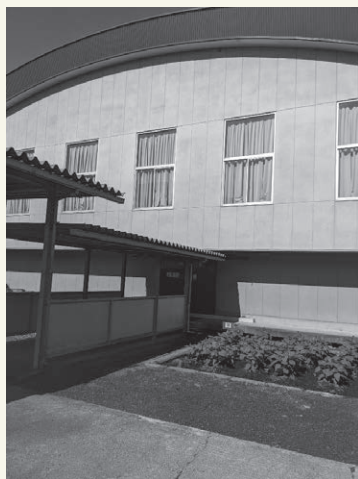
小中学校体育館へのエアコン設置
