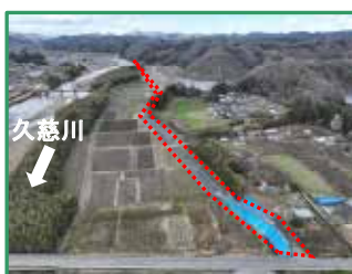
工事箇所の全景（上流から）
