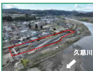
工事箇所の全景（下流から）
