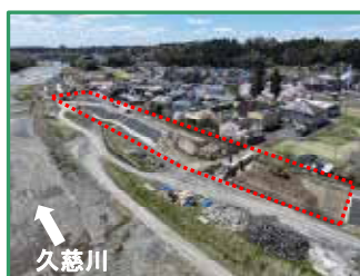
工事箇所の全景（上流から）
