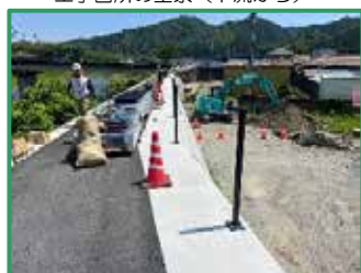
防護柵の設置を行っています
