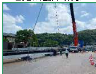
橋桁の揚重作業を行っています
