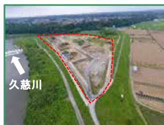
工事箇所の全景（上流から）
