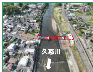
工事箇所の全景（下流から）
