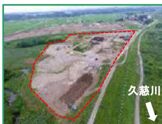
工事箇所の全景（下流から）
