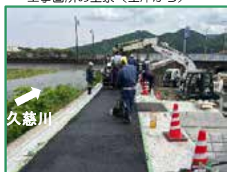
アスファルト舗装を行っています
