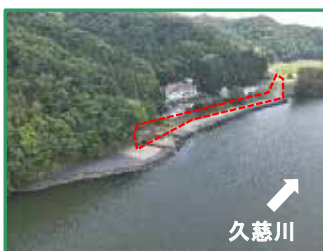
工事箇所の全景（右岸から）
