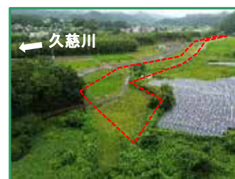
工事箇所の全景（下流から）
