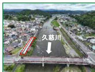
工事箇所の全景（下流から）
