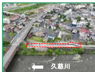
工事箇所の全景（左岸から）
