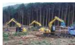
▲伐採現場の作業風景
