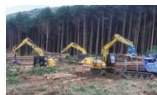
▲伐採現場の作業風景
