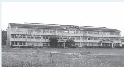
廃校の利活用が重要な課題（西中学校）
