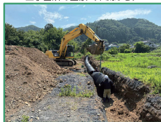
仮水路の設置を行っています
