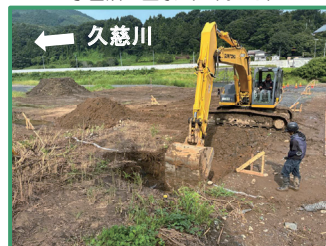
樋管本体の床掘りを行っています
