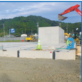
災害時活動施設(芝生広場内) 地下埋設型雨水貯留槽 令和7年7月完成
