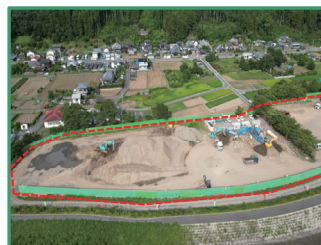
ストックヤードの全景（上流部）
