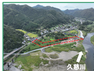
工事箇所の全景（上流から）
