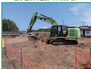
竹根の撤去を行っています
