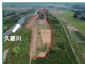
工事箇所の全景（上流から）
