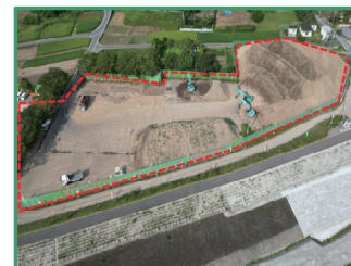
ストックヤードの全景（下流部）
