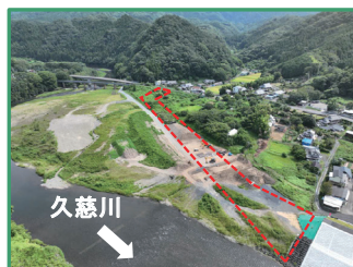
工事箇所の全景（下流から）
