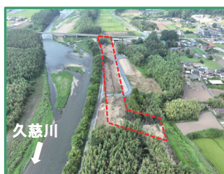
工事箇所の全景（下流から）
