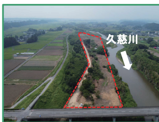
工事箇所の全景（下流から）
