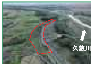
工事箇所の全景（上流から）
