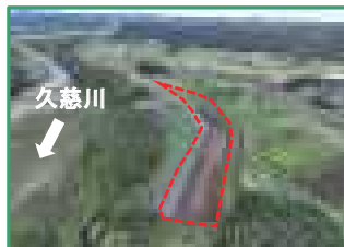
工事箇所の全景（下流から）
