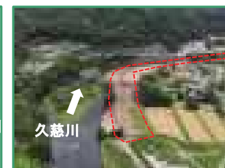
工事箇所の全景（上流から）
