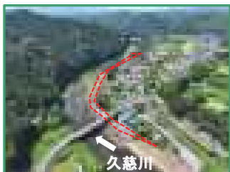
工事箇所の全景（上流から）
