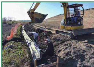
堤脚水路の設置を行っています
