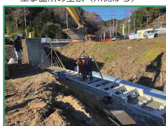
護岸（ブロック積）の整備を行っています
