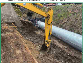
護岸（ブロック積）のための床掘作業を行っています
