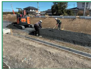
砕石舗装の敷均しをしています
