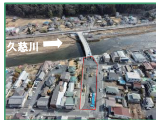
工事箇所の全景（右岸側から）
