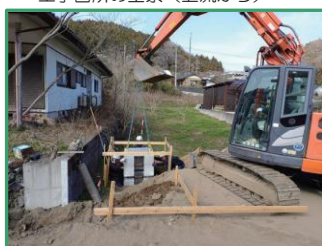
集水橋を設置しています
