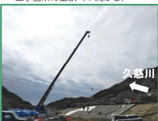
連節ブロックを設置しています
