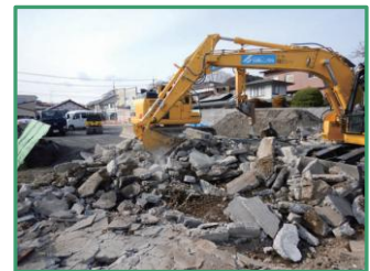
基礎コンクリートを取壊しています
