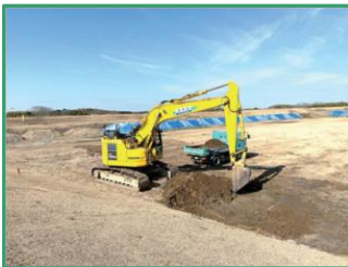
築堤のための表土のすき取りをしています
