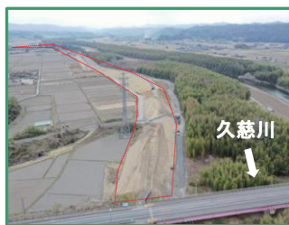
工事箇所の全景（下流から）
