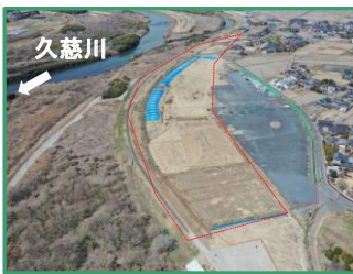
工事箇所の全景（下流から）
