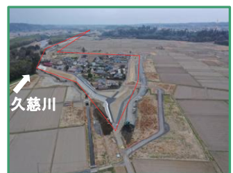
工事箇所の全景（上流から）
