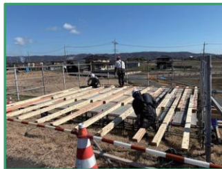
見学台を設置しています
