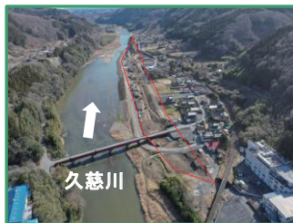
工事箇所の全景（上流から）
