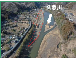
工事箇所の全景（下流から）
