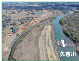
工事箇所の全景（上流から）
