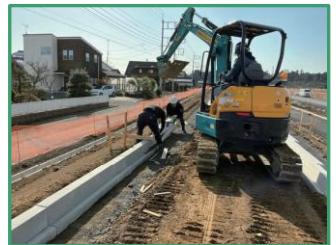
歩車道ブロックを設置しています
