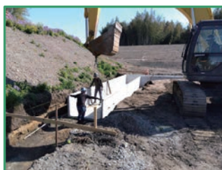
堤外水路を設置しています
