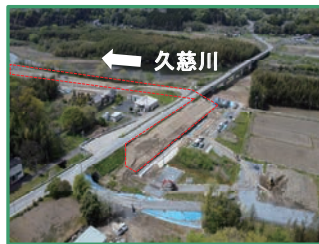
工事箇所の全景（上流から）
