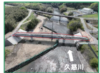
工事箇所の全景（上流から）
