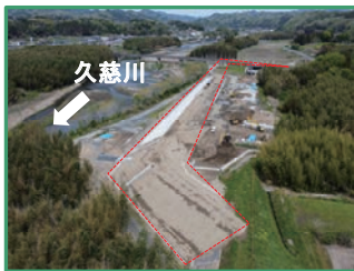
工事箇所の全景（下流から）
