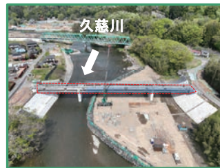
工事箇所の全景（下流から）
