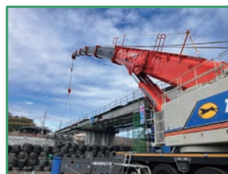
主桁の架設を行っています
