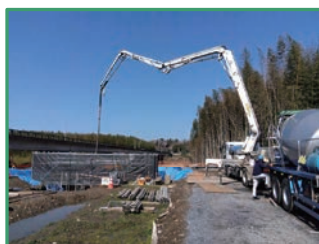
涵渠のコンクリートを打設しています
