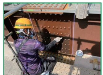
主桁の塗装を行っています
