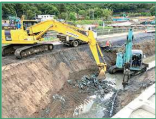
護岸基礎の床掘を行っています
