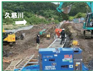
ブロック積みを行っています
