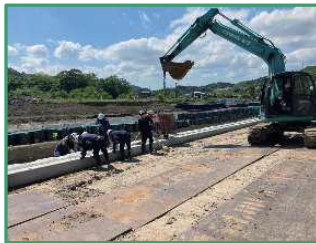
ブロック積みを行っています
