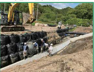
ブロック基礎の間詰めを行っています
