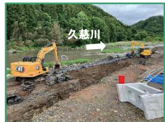
仮締切りを撤去しています
