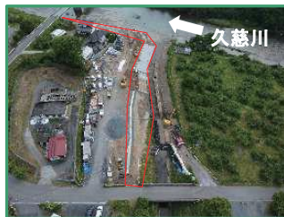
工事箇所の全景（支流から）
