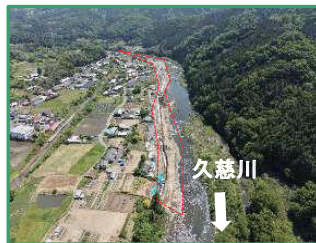
工事箇所の全景（下流から）
