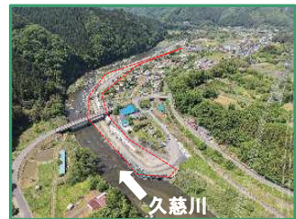
工事箇所の全景（上流から）
