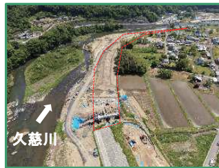
工事箇所の全景（上流から）
