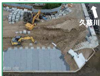
護岸ブロックを設置しています
