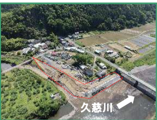
工事箇所の全景（右岸から）
