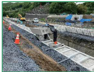
ブロック積みを行っています
