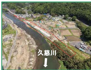
工事箇所の全景（下流から）
