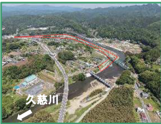
工事箇所の全景（下流から）
