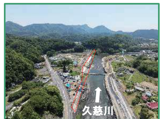
工事箇所の全景（上流から）
