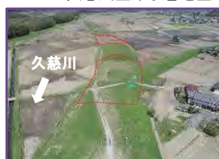
工事箇所の全景（下流から）
