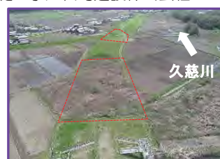
工事箇所の全景（上流から）
