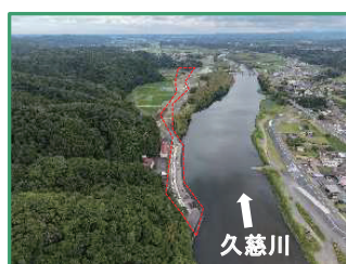
工事箇所の全景（上流から）
