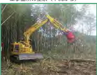
竹林の伐採作業を行っています
