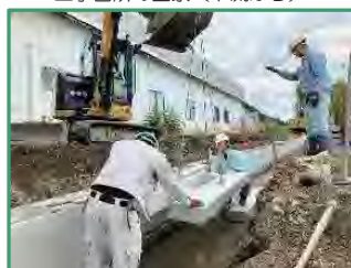
ブロック積みを行っています
