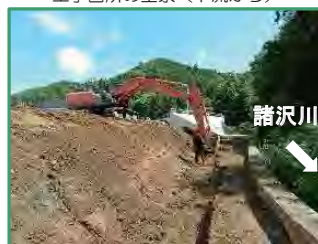
基礎ブロックの床掘を行っています
