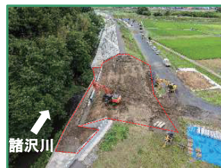
工事箇所の全景（上流から）
