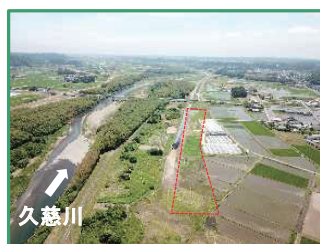
工事箇所の全景（上流から）
