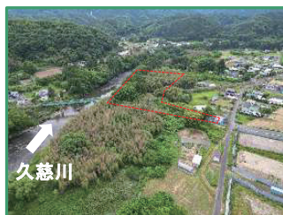
工事箇所の全景（上流から）
