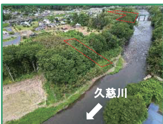
工事箇所の全景（下流から）
