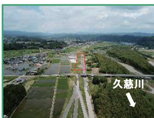
工事箇所の全景（下流から）
