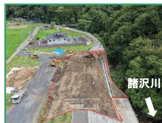
工事箇所の全景（下流から）
