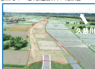
工事箇所の全景（上流から）
