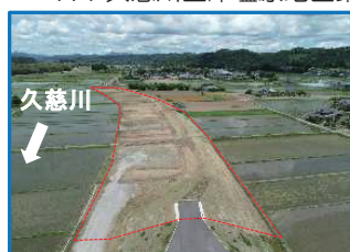
工事箇所の全景（下流から）
