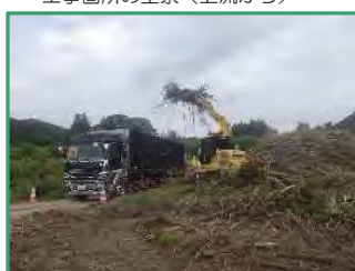
竹根の横込み作業を行っています
