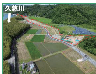
工事箇所の全景（下流から）
