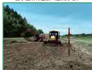
築堤のための盛土作業を行っています
