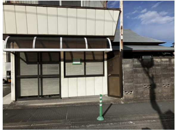
店舗、木造 2 階建、床面積 39.66 m 2 、 昭和 46 年築
