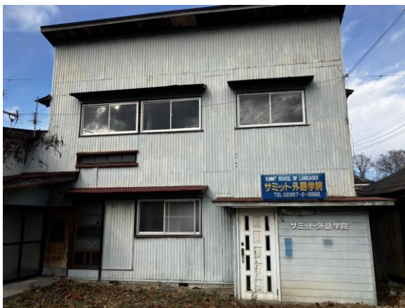
併用住宅（一般住宅）、木造 2 階建、 床面積 87.76 m 2 、昭和 48 年築
