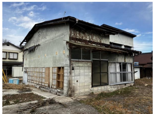
店舗（遊戯場）、木造平家建、 床面積 103.3 m 2 、昭和 41 年築
