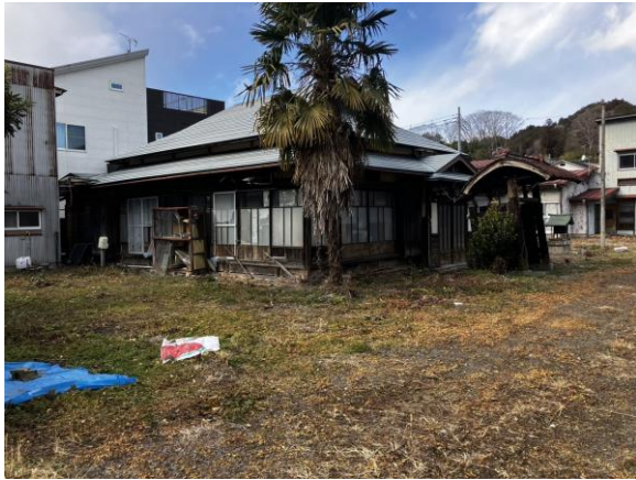
専用住宅（一般住宅）、木造平家建、 床面積 123.96 m 2 、昭和 7 年築
