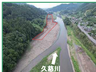
工事箇所の全景（上流から）
