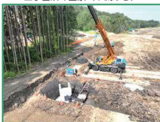
集水橋を設置しています
