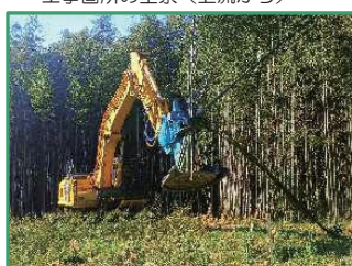
竹林の伐採作業を行っています
