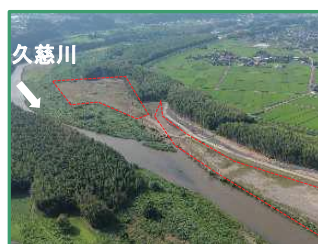
工事箇所の上流全景（右岸から）
