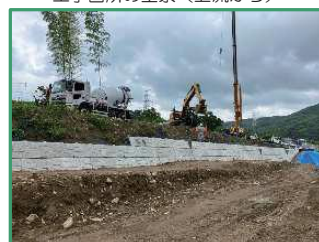
ブロック積を行っています
