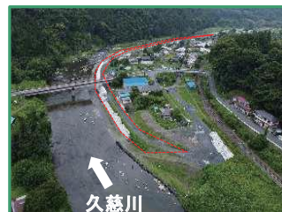
工事箇所の全景（上流から）
