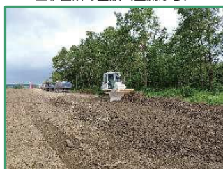
工事用道路の整備を行っています
