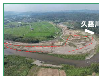
工事箇所の下流全景（右岸から）
