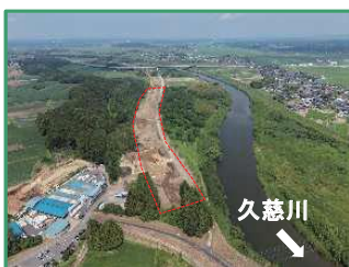
工事箇所の全景（下流から）
