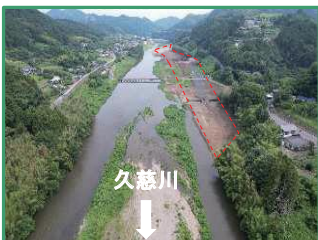
工事箇所の全景（下流から）
