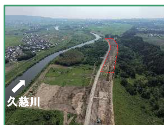
工事箇所の全景（上流から）
