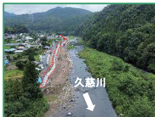
工事箇所の全景（下流から）
