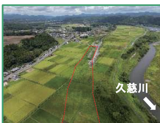
工事箇所の全景（下流から）
