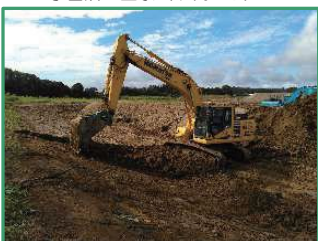
土砂の掘削作業を行っています
