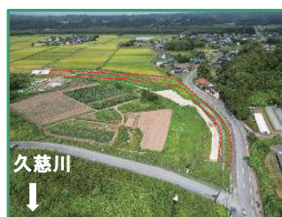
工事箇所の上流全景（下流から）
