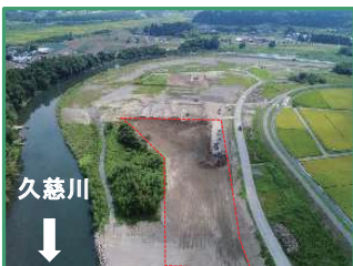
工事箇所の全景（下流から）
