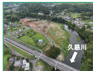
工事箇所の全景（上流から）
