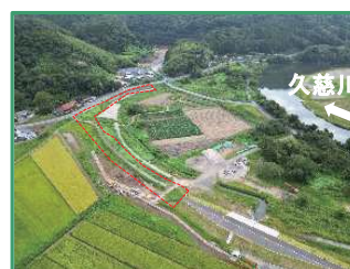
工事箇所の下流全景（上流から）
