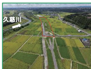
工事箇所の全景（上流から）
