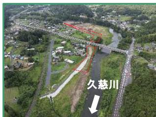
工事箇所の全景（下流から）
