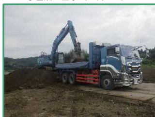
土砂の横込み作業を行っています
