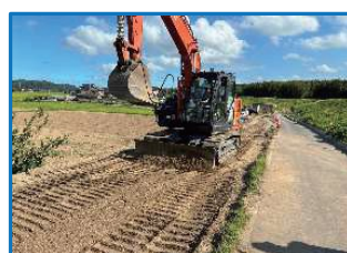
仮設坂路の拡幅を行っています
