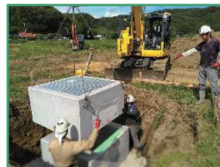
集水枡を設置しています
