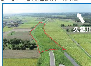
工事箇所の全景（上流から）
