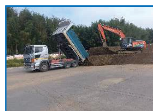
築堤土の受け入れを行っています
