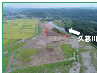
工事箇所の全景（上流から）
