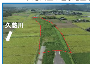
工事箇所の全景（下流から）
